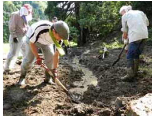
ピオトープ整備
